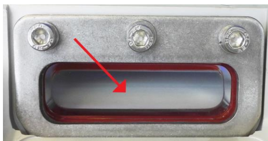
Figura 20 - Limpieza de prismas
